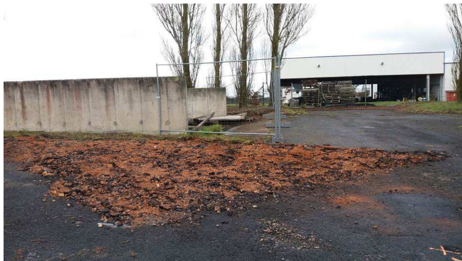
Figure 4 : Terrassement des enrobés
