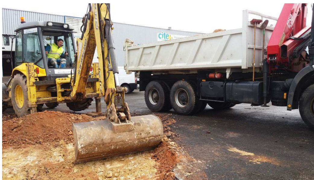
Figure 5 : Terrassement des matériaux impactés
