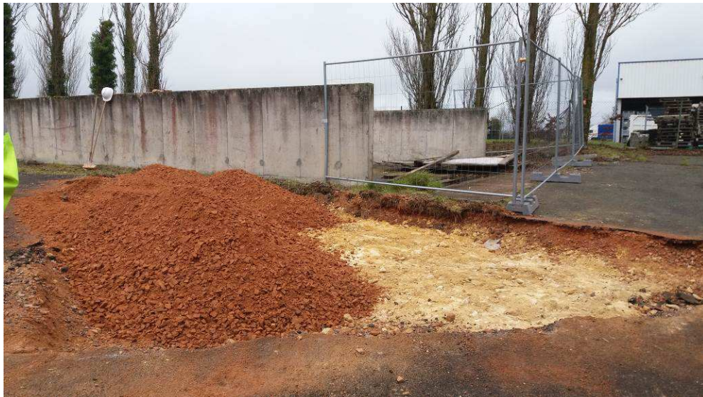
Figure 6 : Remblaiement de la zone
