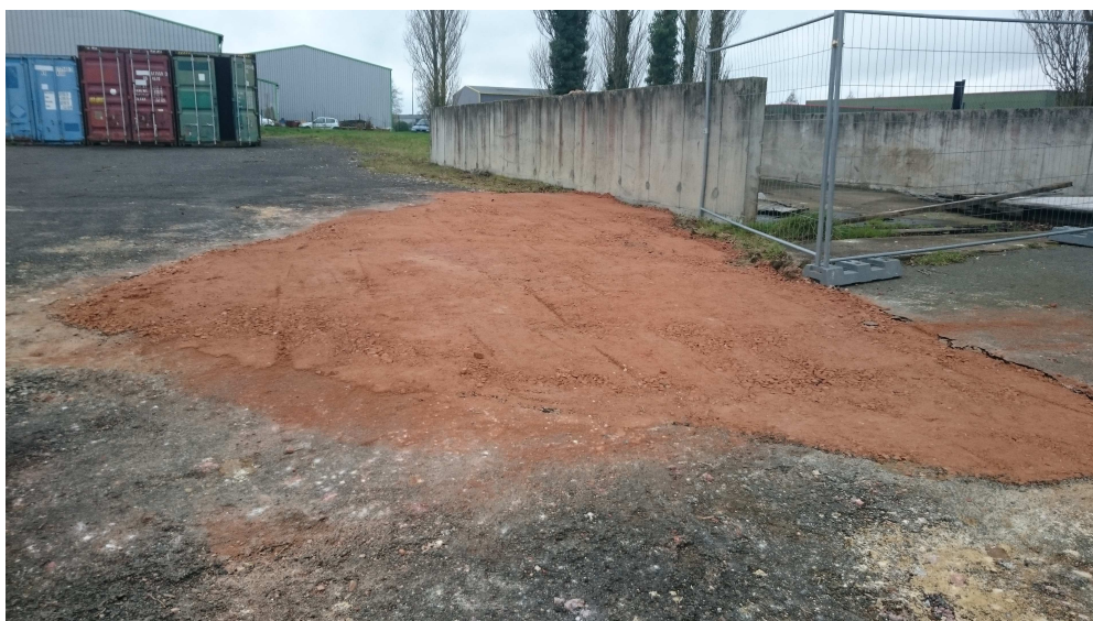
Figure 7 : Remise au propre du chantier, remblaiement compacté
